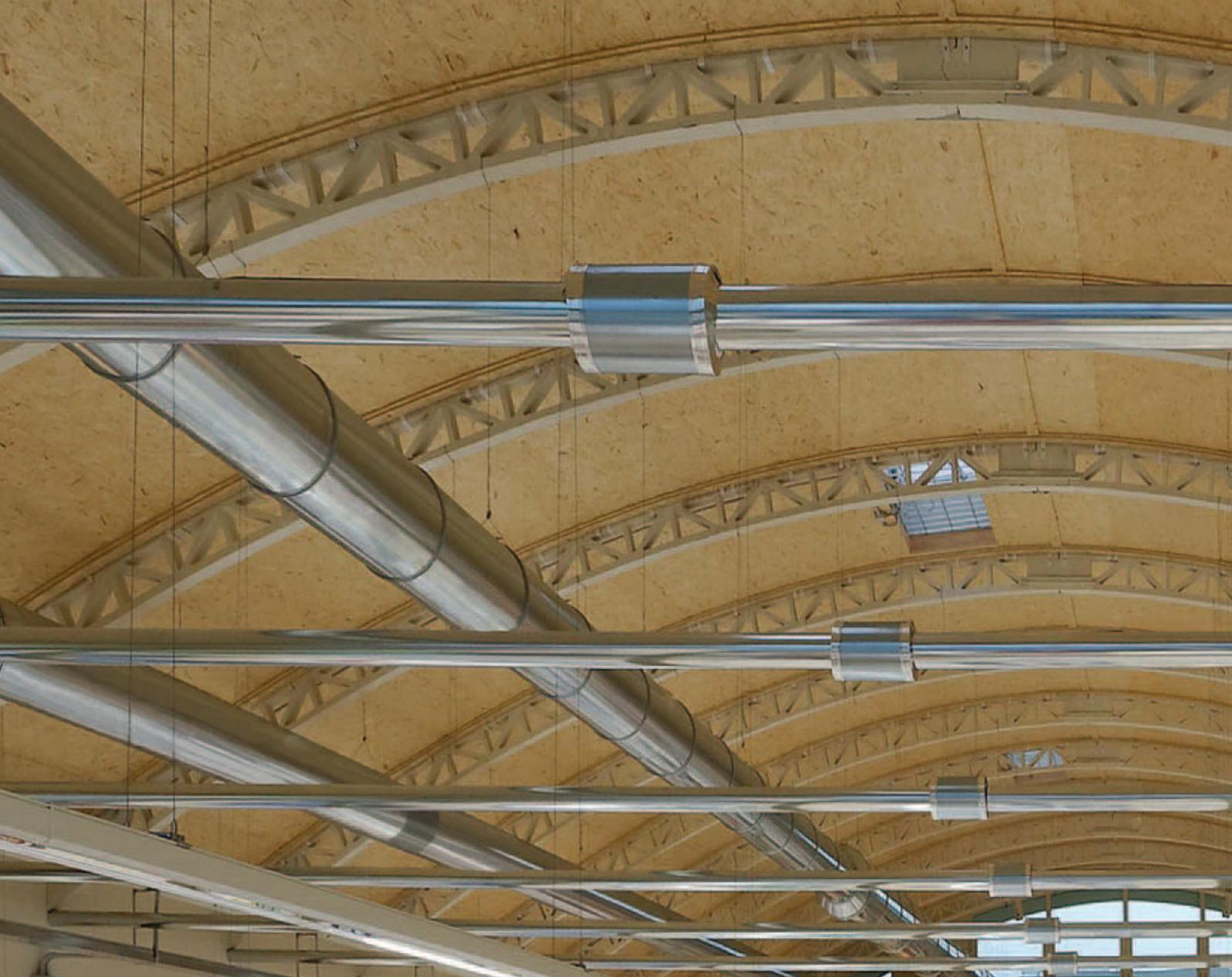
Según el ordenamiento europeo referente a los ensayos de resistencia al fuego, no está actualmente disponible un protocolo de ensayo para elementos estructurales de acero sometidos a tracción y particularmente para tirantes de acero. Dado que este elemento constructivo está todavía difundido en las obras, existe una exigencia de poder probar sistemas de protección con una metodología de ensayo que técnicamente sea lo más próxima posible al espíritu de las normas Europeas.
