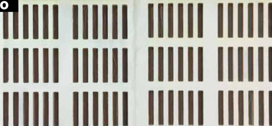
Las REJILLAS DE AIREACIÓN PLANAS están hechas con placas de silicatos ranuradas. Están equipadas con material intumescente que se expande en caso de incendio, cerrando completamente cada punto de penetración.
