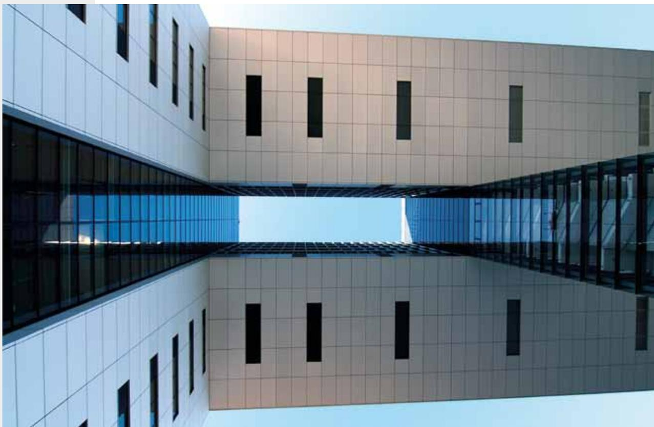
El sistema UNIFIX ofrece excelentes soluciones innovadoras gracias a las altas prestaciones de los paneles UNIPAN®. Estos paneles, de cemento y otros componentes, se caracterizan por el acabado de superficie con doble capa de fibra de vidrio y recubrimiento polimérico. Esto las hace ideales para el uso externo ya que soportan heladas, el agua, y la humedad prolongada.
